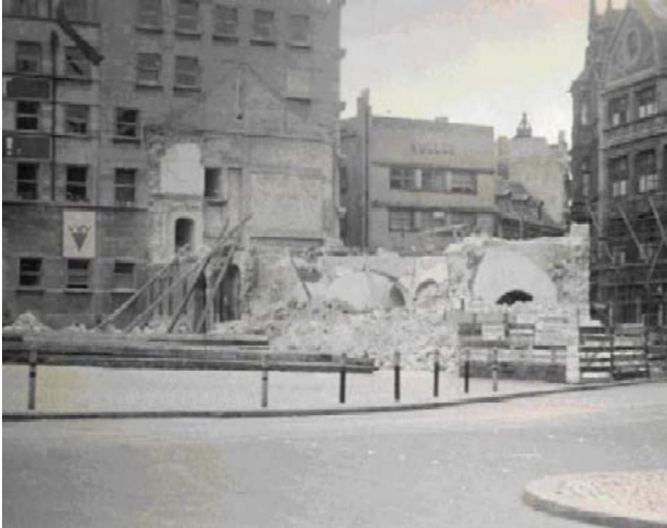
Abriss des Barockflügels des Alten Rathauses (bis 1950) Quelle: Sammlung K.-P. Gneist
